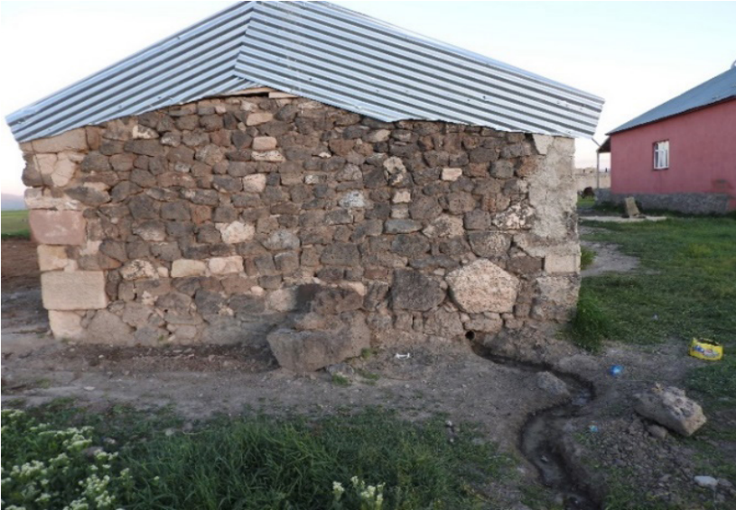
Resim 2. Van/Çaldıran Hanköy. Kervansaraya ait taşlarla inşa edilen binalardan biri.
